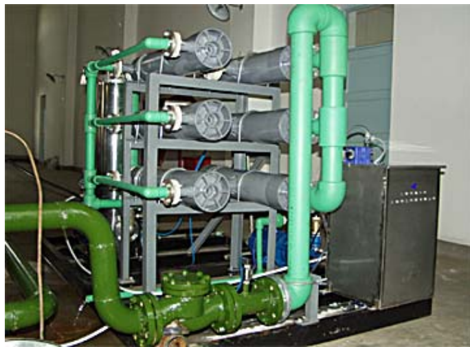
Membrankontaktorsystem zur Kessel-Sauerstoffentgasung von Shen Lan
