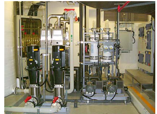
Zweite Stufe des Liqui-Cel Polishing System für CO2 und O2 Removal
